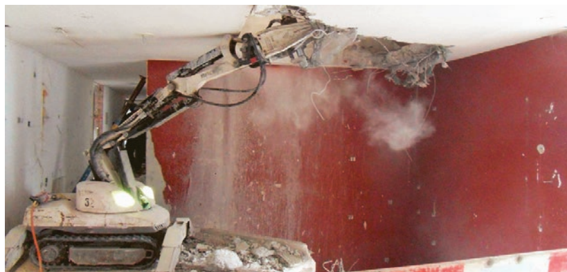
Ausbruch für Liftschacht
