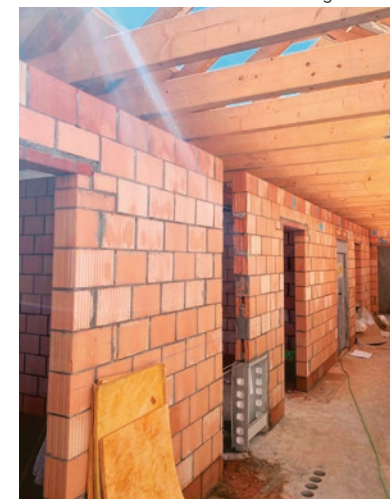
Neue Zimmer im Dachstock
